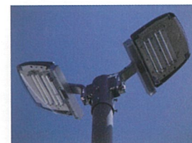
ポールキャップ取付け
