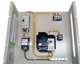
※JIS・EIA規格に対応したラック収納形各種免雷盤を製作します。
